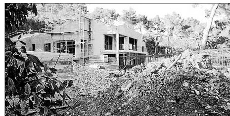
Avisan que la obra se realiza sin la licencia correspondiente.
